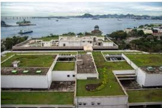
O PJERJ possui 11 prédios com teto verde telhado verde que permitem um melhor controle da temperatura interna, diminuindo o calor do prédio, minimiza o uso do sistema de climatização e gera, assim, economia no consumo de energia elétrica.
