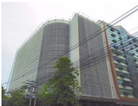
Fachada com tela de proteção
