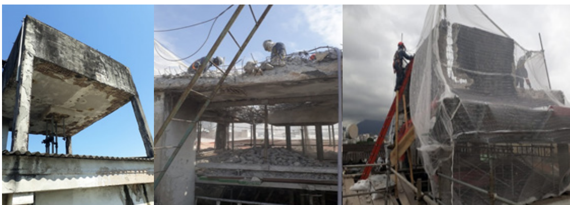
Antes da demolição
