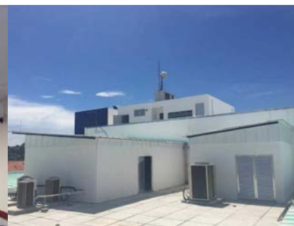
Construção de 05 casas de máquina de ar condicionado nas coberturas
