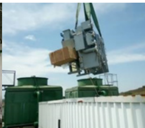
Içamento do Chiller
